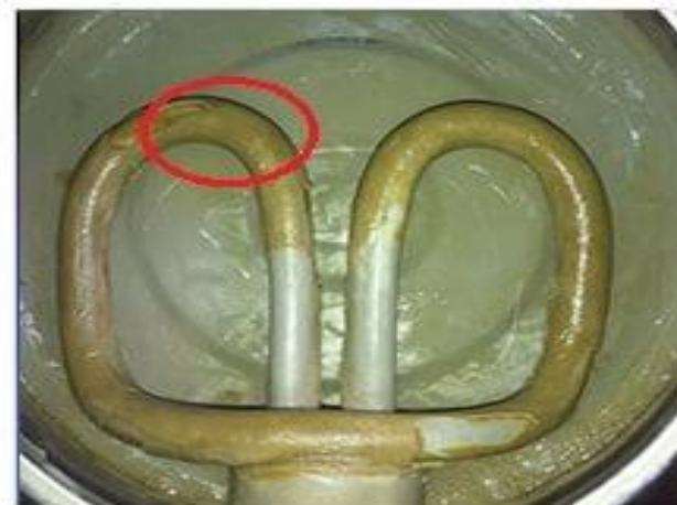
Bình đun, ấm đun nước bị đóng cặn hồng ruột
